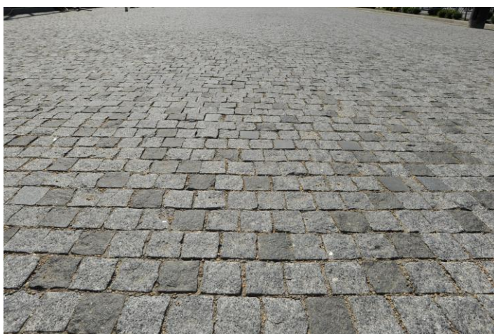
Nájezdy k rodinným domům Žulové dlažební kostky 100/100/100 mm
