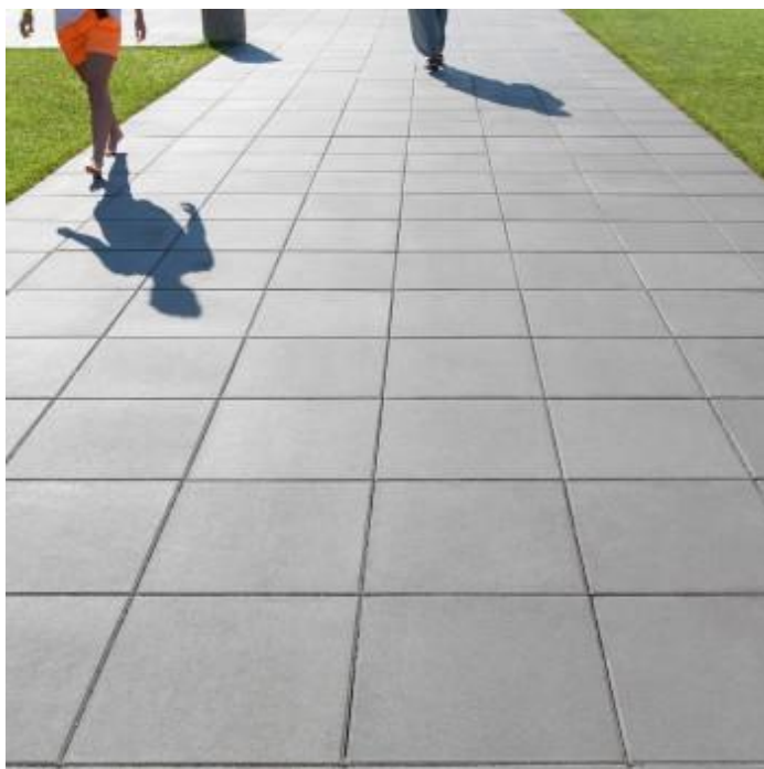
Pochozí plochy u multifukčního hřiště Dlažba betonová hladká přírodní 400/400/40 mm
