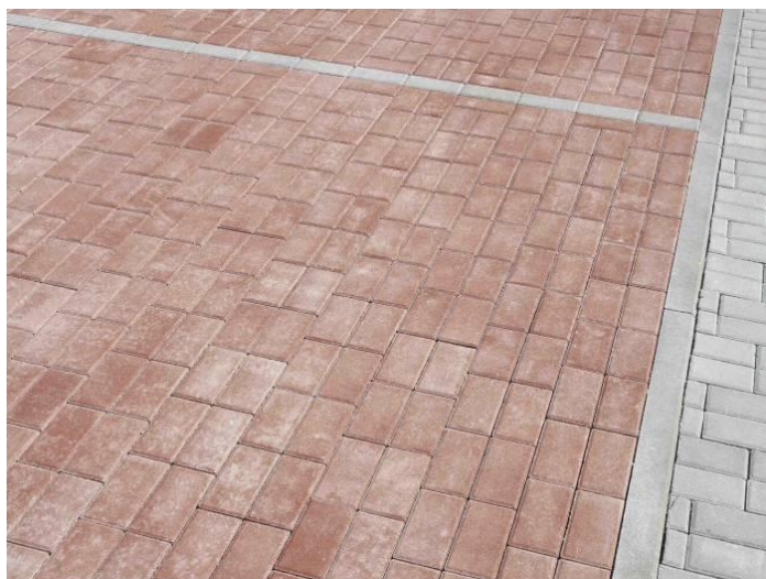
Parkovací stání Dlažba betonová červená 100/200/60 mm
