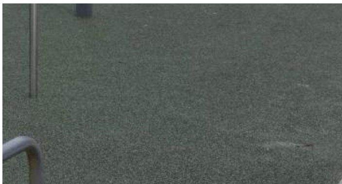
Povrch multifukčního hřiště (dopadové plochy) Litý polyuretan – elastic EPDM – cihlová červená RAL 7038
