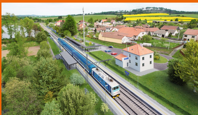
Modernizovaná zastávka Ořechov
